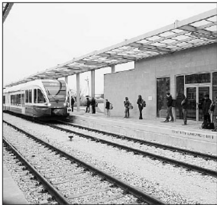
La stazione dei treni di Cividale
