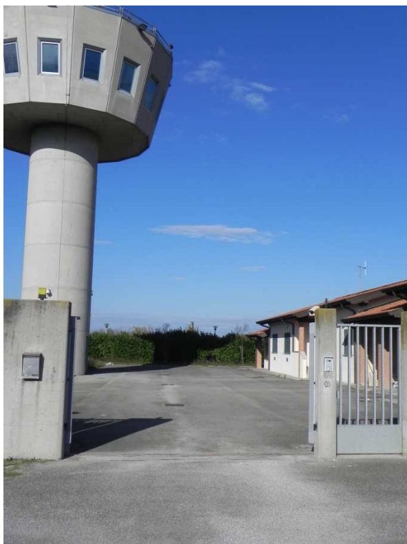
Fig 3. - Torre radar, piazzale e palazzina uffici
