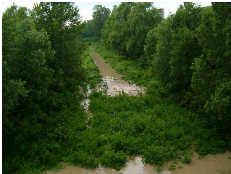
Manufatto di scarico nel Tagliamento dell'idrovora comunale di Latisanotta (portata 1,4 mc/s)
