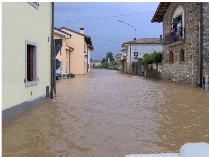
Allagamento di Pavia di Udine
